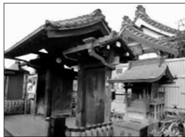
萬年山勝林寺正門。現在は新本堂と納骨堂を建築工事中。
